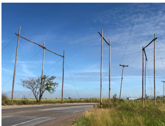
Figura 10.2. Exemplos de estruturas de travessias de proteção de vias instaladas pelo empreendedor.
