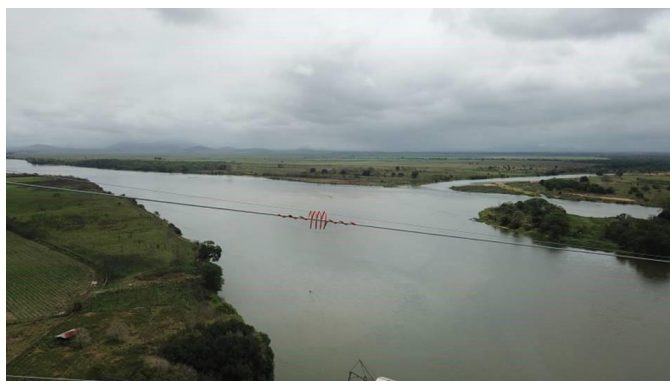
Figura 10.7. Protetor Preformado para Pássaros de Grande Porte instalado em cabo de linha de transmissão paralela ao empreendimento.
