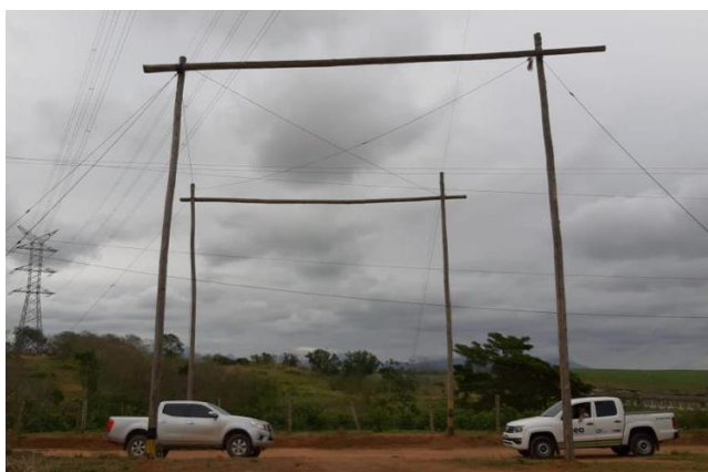
Figura 10.2. Exemplos de estruturas de travessias de proteção de vias instaladas pelo empreendedor.
