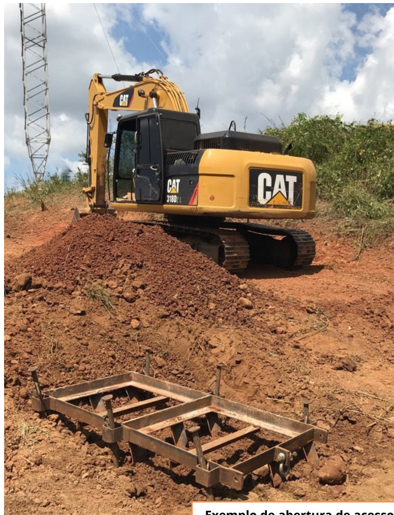
Exemplo de abertura de acessos
