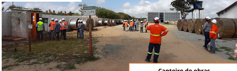
Canteiro de obras
