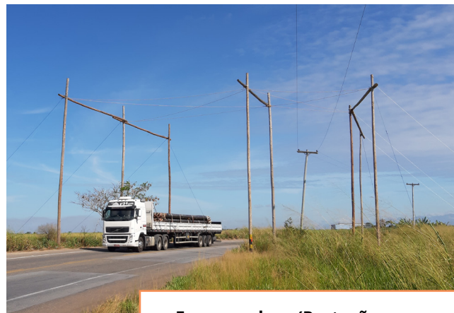
Empacadura (Proteção para passagem de cabos elétricos)
