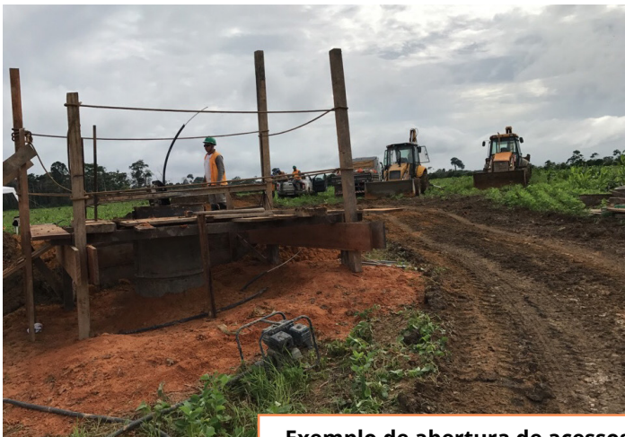
Exemplo de abertura de acessos
