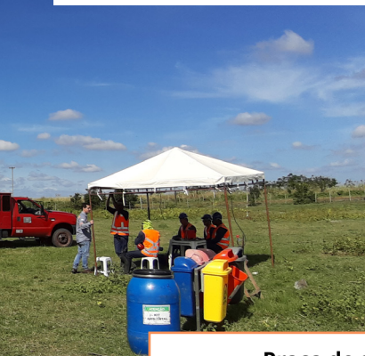
Praça de serviço
