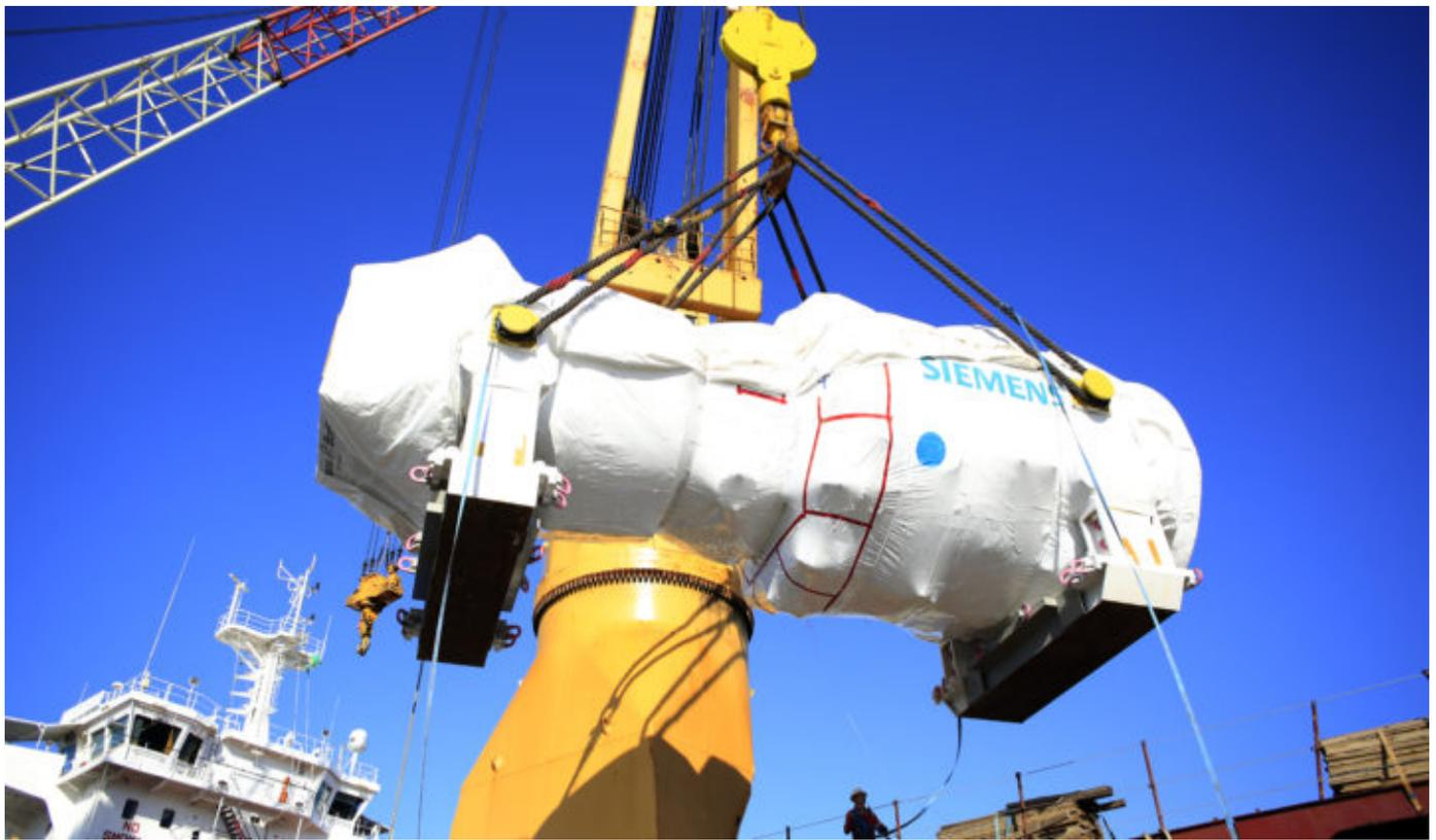
Turbina a gás fornecida pela Siemens para a termelétrica GNA I, no Porto do Açu (RJ)
