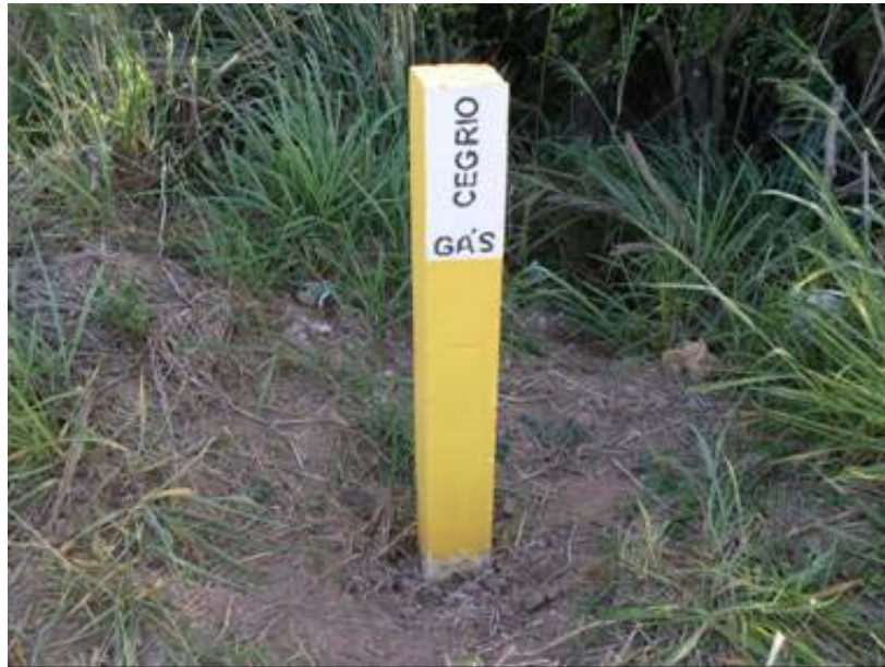
Foto 2.5.1-13 - Gás encanado nas margens da Rodovia RJ - 216 (entre os vértices V21 e V22).
