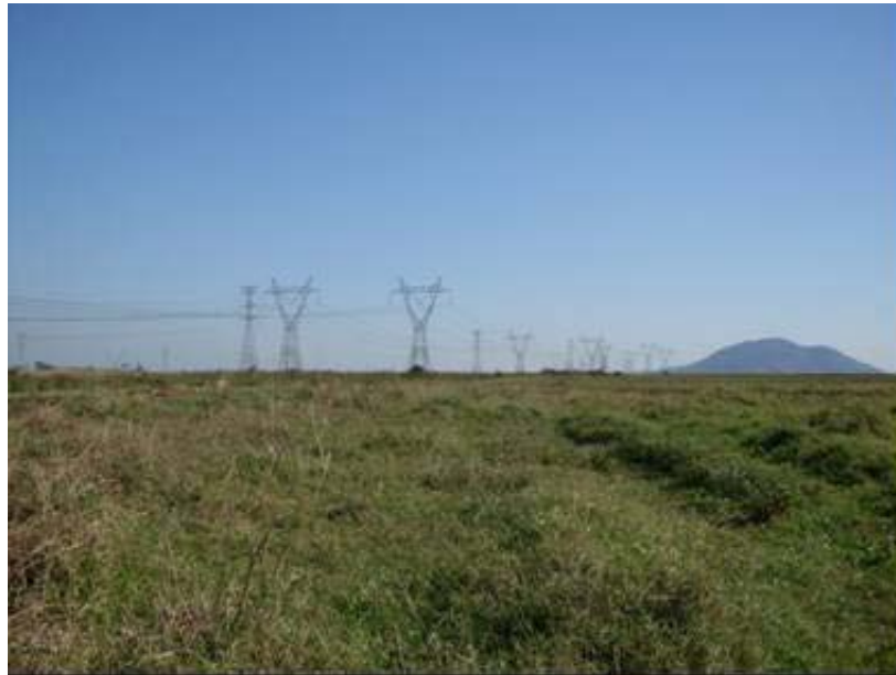
Foto 2.5.1-17 – Gasoduto: Cabiúnas – Vitória de propriedade da Petrobras e ao fundo LT's 345 kV Campos - Macaé e 138 kV Campos - Rocha Leão (proximidades do vértice V32).
