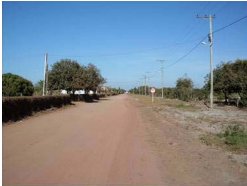
Foto 2.5.1-7 – Rede de distribuição de energia da Ampla e Estrada de Sacudantas (entre os vértices V05 e V0).
