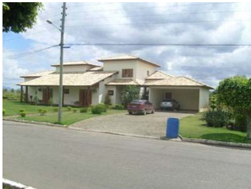
Foto 4.3.11-18 – Casa já habitada no condomínio
