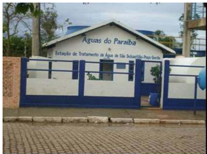
Foto 4.3.11-9 - Estação de Tratamento de Água
