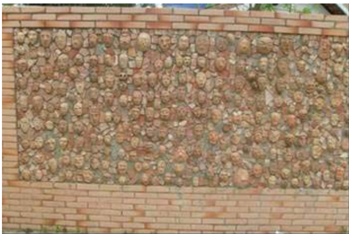
Foto 4.3.11-12 – Detalhe do muro do Colégio, decorado com trabalhos realizados pelos alunos na oficina de cerâmica
