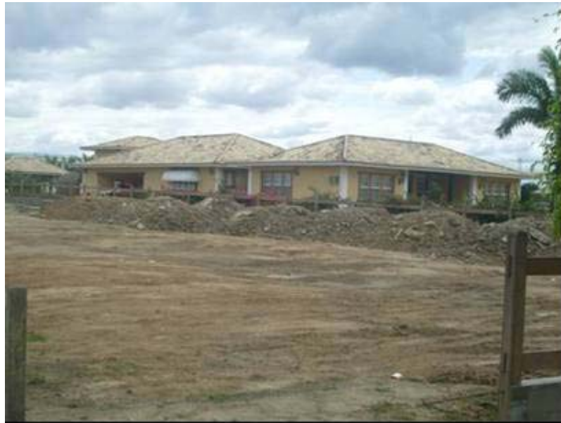
Foto 4.3.11-19 - Casa em construção no condomínio Nashville
