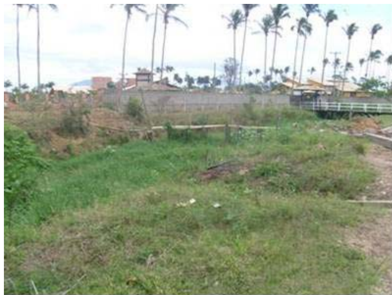
Foto 4.3.11-20 - Vala e muro que separam o condomínio Nashville e o loteamento Parque Esplanada
