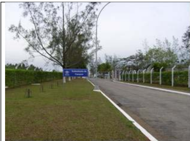
Foto 2.6-5 - Entrada da Subestação Campos - Campos dos Goytacazes - RJ
