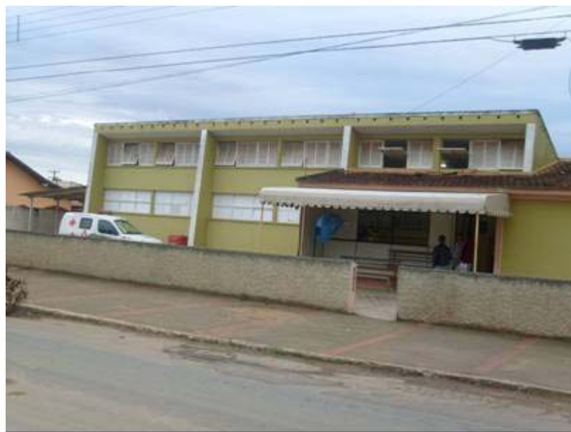
Foto 4.3.11-10 – Posto de Saúde de São Sebastião de Campos
