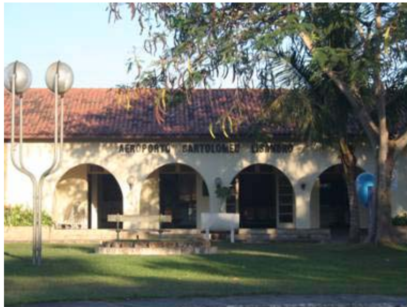
Foto 2.5.1-22 – Aeroporto Bartolomeu Lisandro (nas proximidades da Subestação de Campos de Goytacazes).
