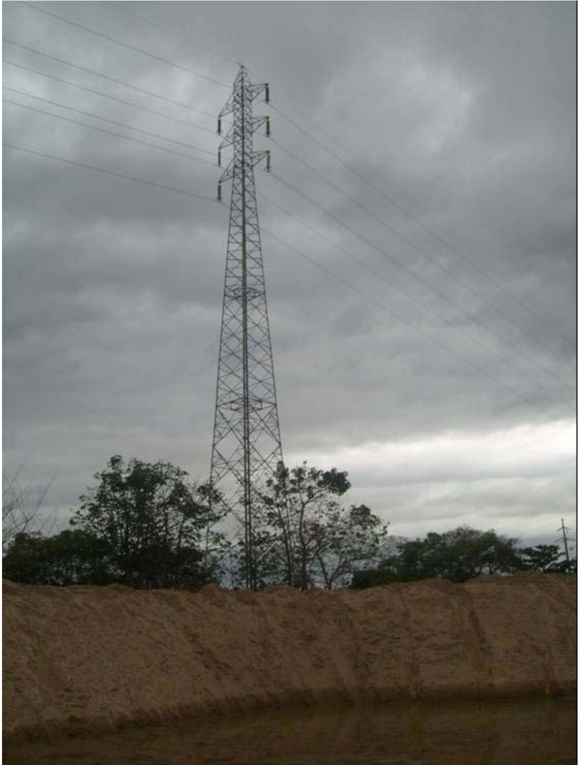
Foto 4.3.11-5 - Mesma jazida, sob outro ângulo. Torres de LT estão situadas nos locais de escavação
