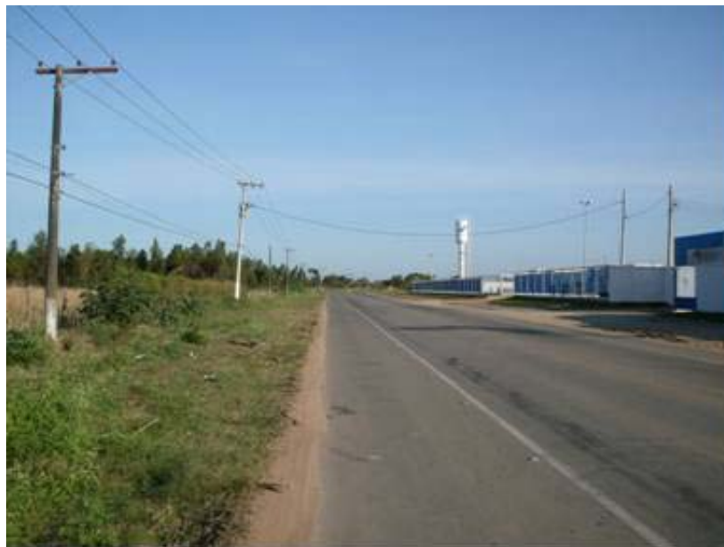
Foto 2.5.1-12 – Cruzamento com rede de distribuição de energia local, Rodovia RJ- 216 e Construtora Torrezani Rodrigues entre os vértices V21 e V22.
