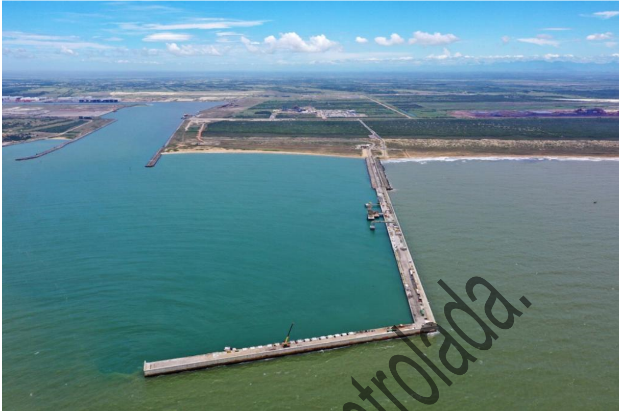
Figura 2 – Vista aérea do Terminal GNL.
