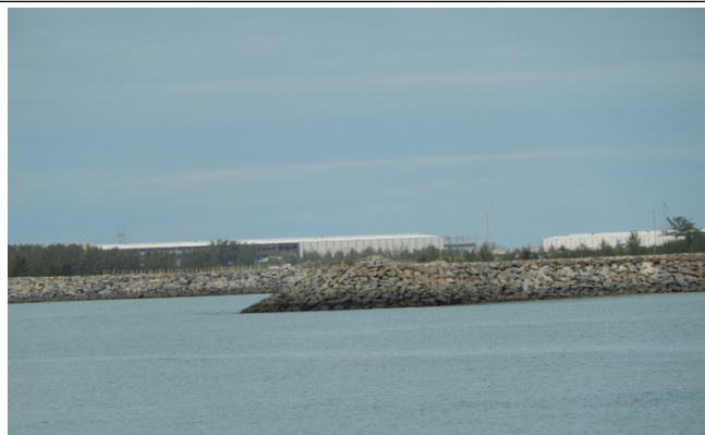
Estruturas artificiais enrocadas do T2.
