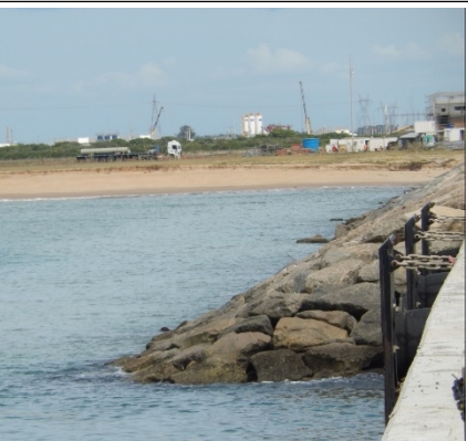
Visão do TGNL, com praia arenosa ao fundo.
