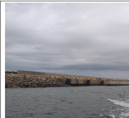
Estrutura artificial do T2.
