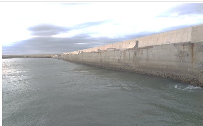
Estrutura artificial interna do Molhe Norte 2.
